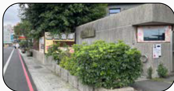
▲ 三芝車站乘車處(二號倉庫前)
